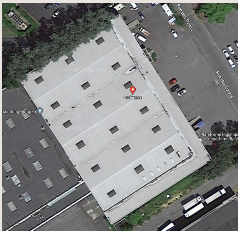
Vue du toit de l'entrepot Carlimpex - Saint Ouen l'Aumône
